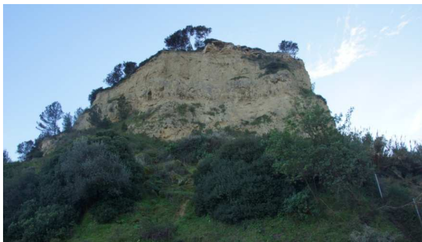
Foto 6 – Escarpa existente a montante da área industrial
