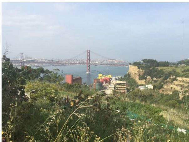
Perspetiva geral da área industrial da Sovena Oilseeds no vale, junto à margem esquerda do Rio Tejo e da envolvente florestal/matos
